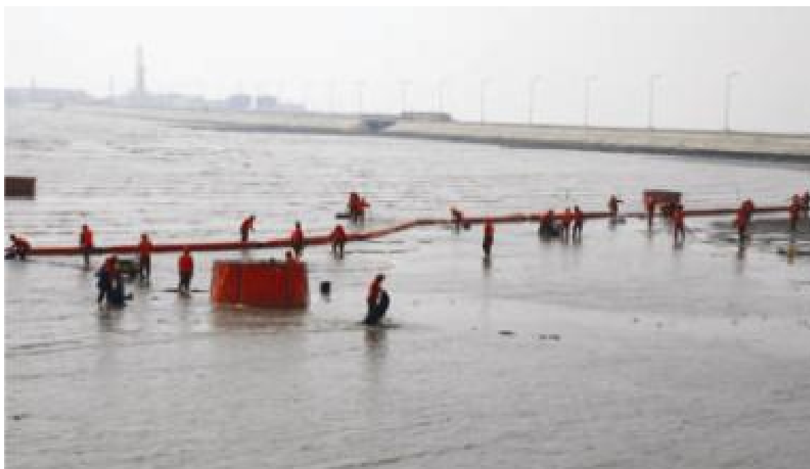
图 13 岸滩围油栏的布放方式二
